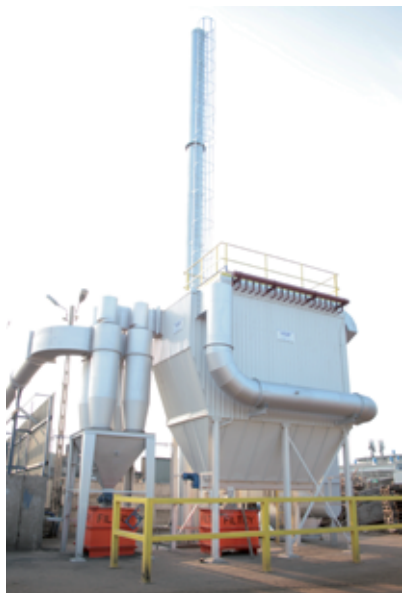
Fot. 2. Instalacja suchego odpylania gazów żeliwiakowych
