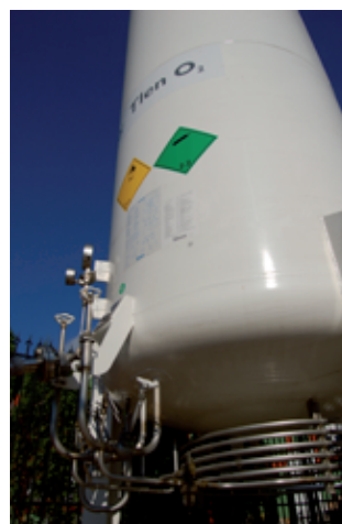
Fot. 1. Widok instalacji tlenowej - zbiornik ciekłego tlenu w Odlewni Żeliwa FANSULD
