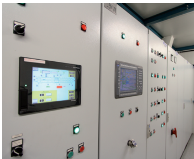
Fot. 7. Nowoczesna sterownia stacji przerobu mas
