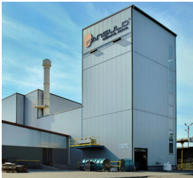
Fot. 5. Stacja przerobu mas (SPM) - widok ogólny hali technologicznej
